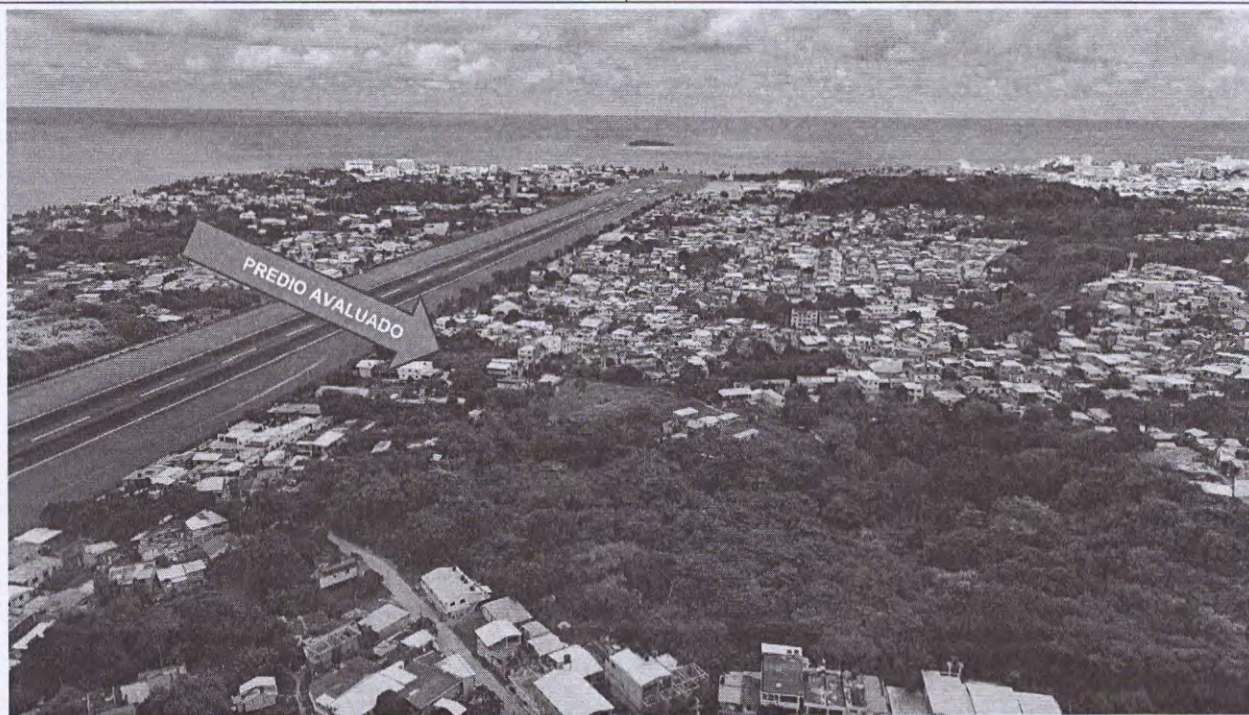
VISTA GENERAL DEL SECTOR
